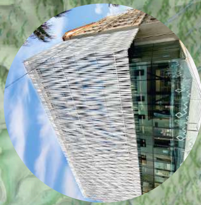
8. Maison de l'eau et de la Méditerranée
