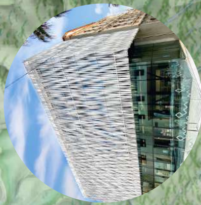
8. Maison de l'eau et de la Méditerranée
