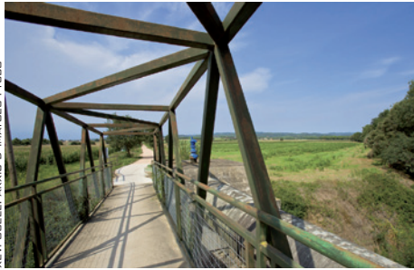
Pont sur la rivière Verneda.
