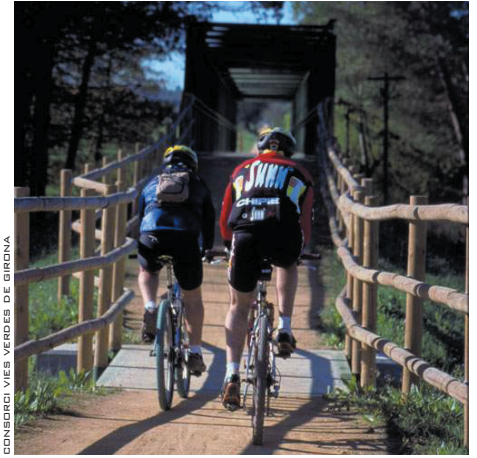
Pont sur l'Onyar sur la voie verte du carrilet.
